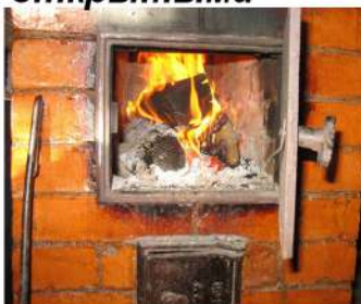
Размер дров должен соответствовать размерам топливника
