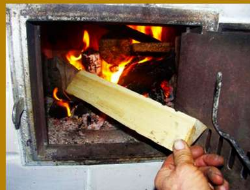
Размер дров должен соответствовать размерам топливника
